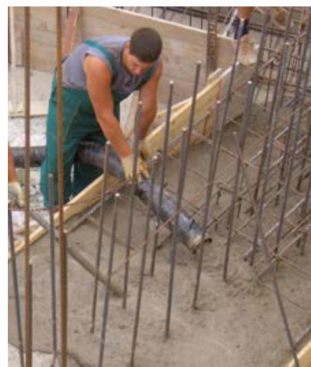
Die P 718 fördert u. a. Feinbeton bis zu einer Korngröße von 32 mm.
